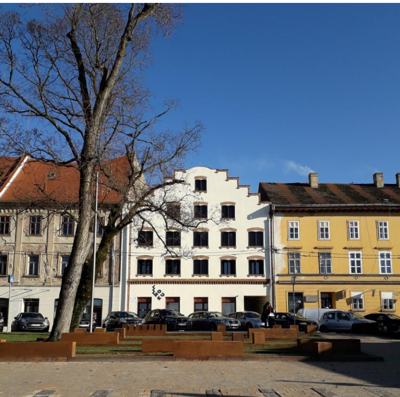
Cjelovita obnova nakon potresa 2020.
